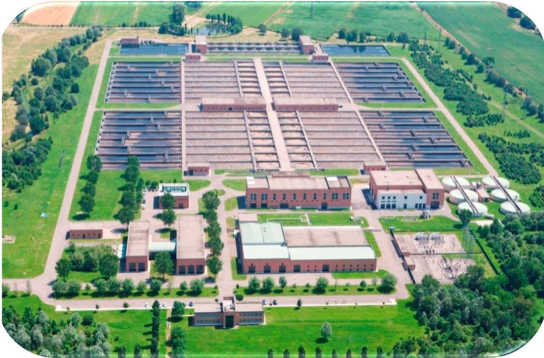
WWTP MILANO NOSEDO
