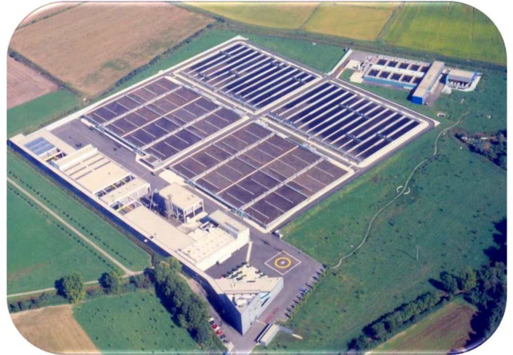
WWTP MILANO SAN ROCCO
